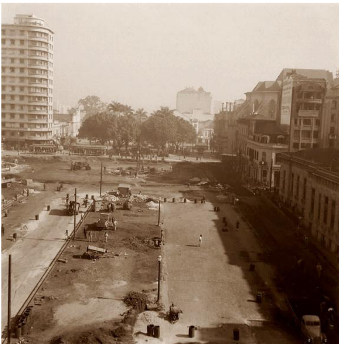
FIGURA 8 – Gabriel Zellai. Largo Sete de Setembro em obras. Sem data. Fotografia.
